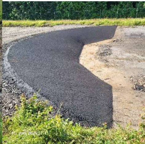
Randbefestigung zur verkürzten Teichanlage - Juni 2025, mit Asphaltierung der beiden Dammböschungen.
